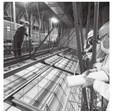
大ホール天井裏で
